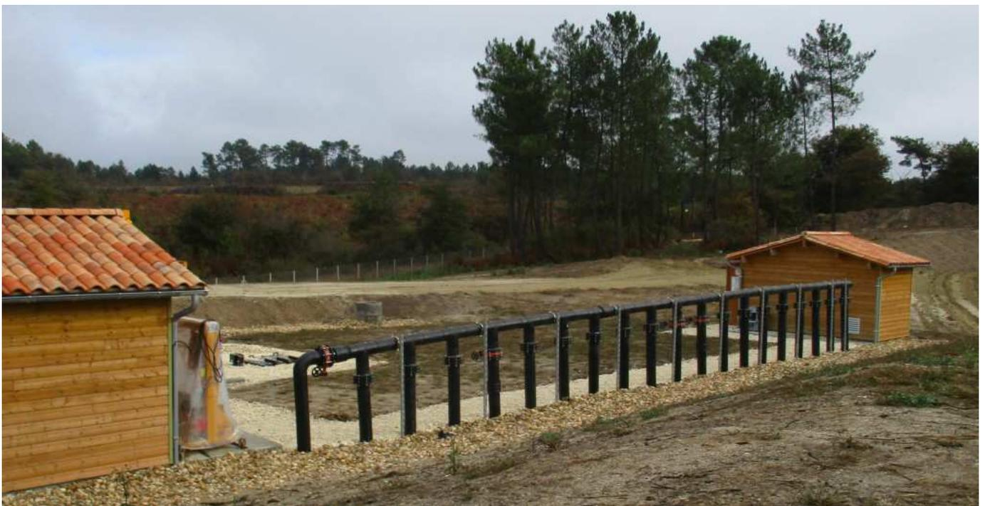
Lorsqu'un casier est plein, il est recouvert d'une membrane étanche, les gaz de fermentation sont ainsi piégés, il n'y a donc plus de rejet dans l'atmosphère mais régulièrement une injection d'eau est pratiquée afin d'assurer une fermentation la plus complète possible.
