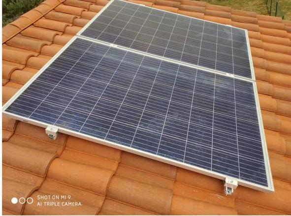
Les panneaux sont en place, leur fixation est facilitée par la qualité des accessoires fournis dans le Kit de fixation
