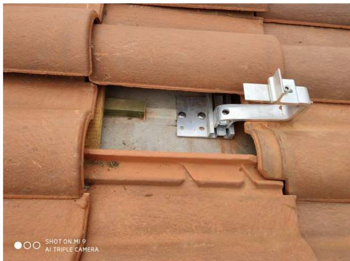
Les crochets de toit ( réglables ) sont fixés sur les chevrons à l'aide de vis autoforeuses fournies dans le Kit.
