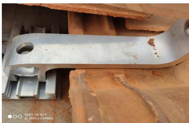
En raison de l'épaisseur des crochets il est parfois nécessaire de meuler les tuiles au niveau du passage des crochets afin que la tuile du dessus ne se soulève pas trop ce qui pourrait favoriser l'entrée d'eau de pluie (bien que les supports soient protégés par les panneaux montés)
