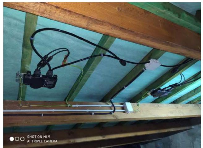
Ici les micro-onduleurs sont positionnés sous la toiture, mais le plus souvent ils sont fixés sous les panneaux car conçus pour être posés à l'extérieur ( IP67 ).
